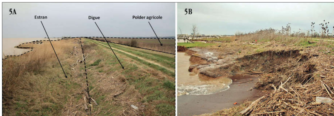
Fig. 5A et 5B - Exemple de dynamique érosive et de phénomène de compression des estrans ( coastal squeeze ) constatés en secteur mésohalin sur l'estuaire de la Gironde, le long de digues protégeant des espaces agricoles situés sur la commune de Saint-Sorlin-de-Cônac. (© BioSphère Environnement)
